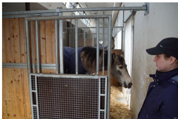
Une paroi coulissante permet de doubler la surface des box.
