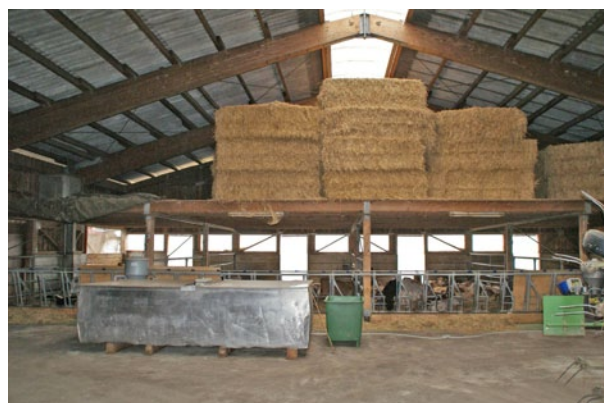
L'étable dans la halle avec aération faîtière. Dépôt de paille au-dessus des boxes des veaux.
