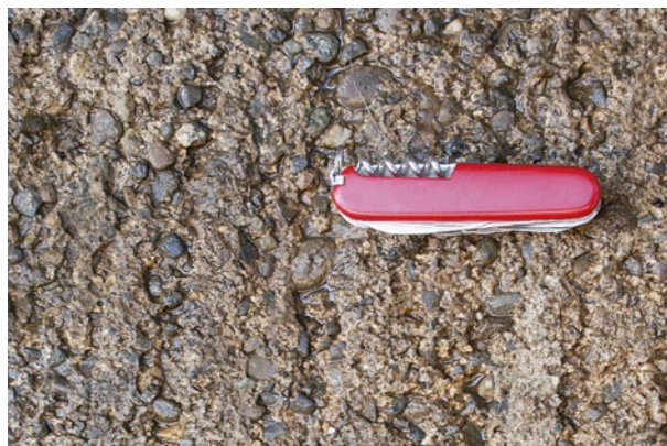
Sol rendu rugueux pour empêcher les glissades dans l'aire d'attente.
