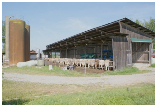
Le nouveau couloir d'alimentation.
