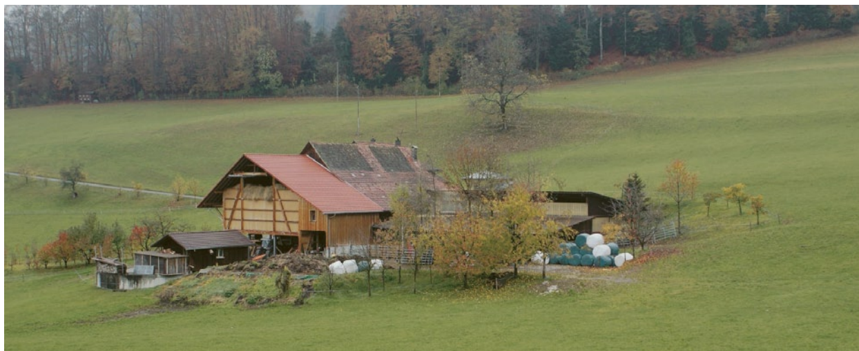
Grange et étable vues du sud.
