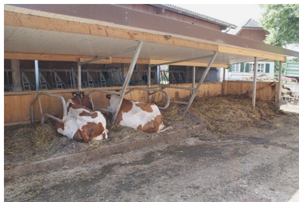
La petite halle de repos avec logettes et périmètre à plan incliné.
