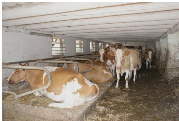
A l'arrière les logettes (avec les piliers à droite).
