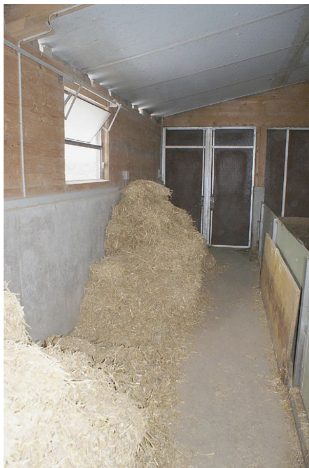
Large de 1 mètre 60, le couloir de l'étable devant les aires sert à stocker la paille.
