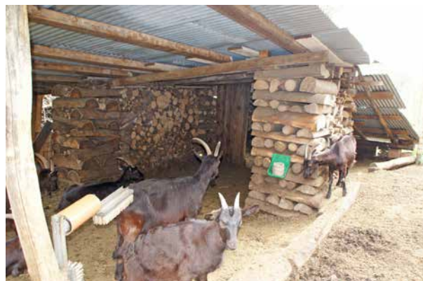
Bûches empliées servant de piliers pour le toit
