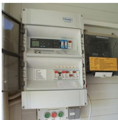
Une horloge astronomique commande l'éclairage ainsi que l'ouverture et la fermeture du poulailler et du jardin d'hiver d'après le lever et le coucher du soleil.
